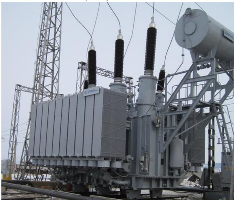
**Автотрансформаторы стационарные силовые масляные трехфазные трехобмоточные класса напряжения 150, 220 кВ общего назначения**
