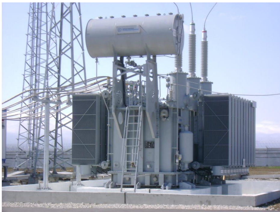
Реакторы компенсирующие масляные трехфазные двухобмоточные 220 кВ
